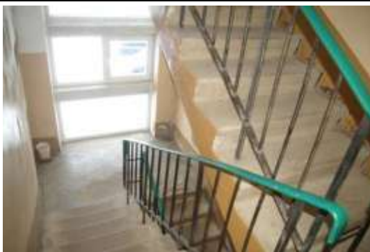
Dzīvojamā ēka ar kadastra apzīmējumu 6468 003 0046 001, koplietošanas telpa
